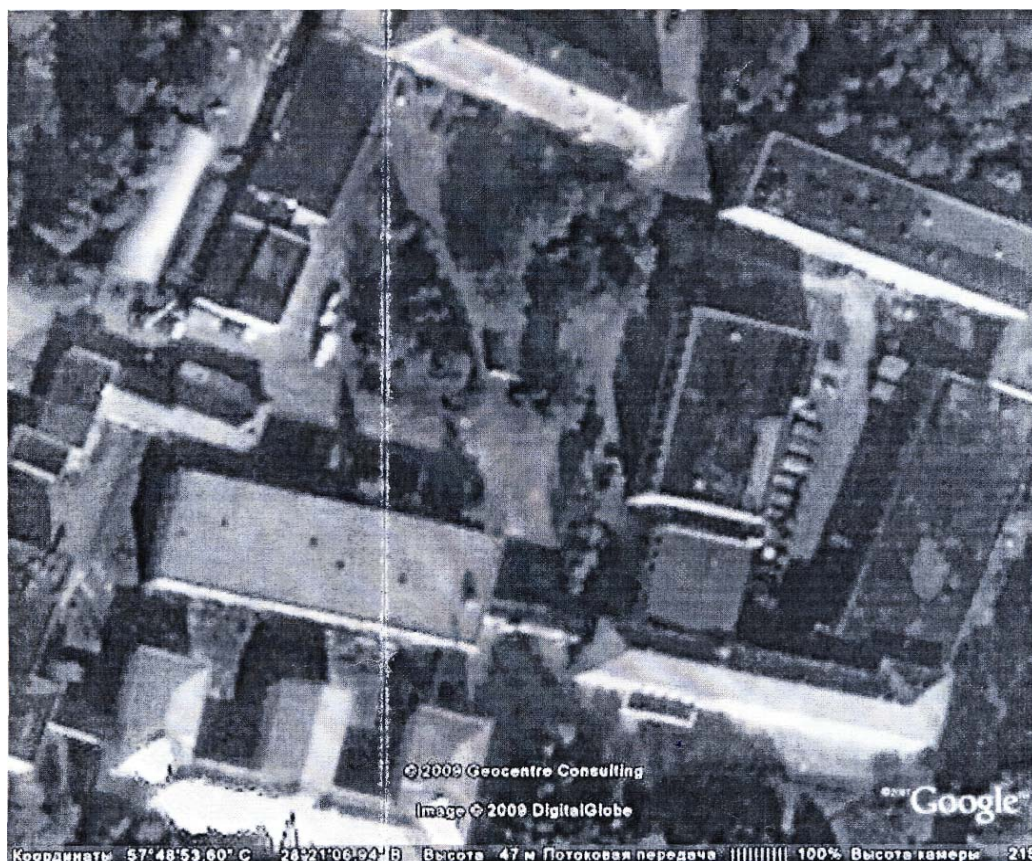
Фото 1. Космический снимок главного корпуса Псковского государственного политехнического института
