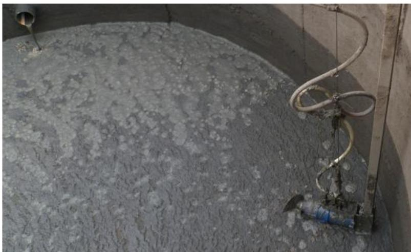
**Рис. 1.** Погружная мешалка пропеллерного типа в отстойнике
