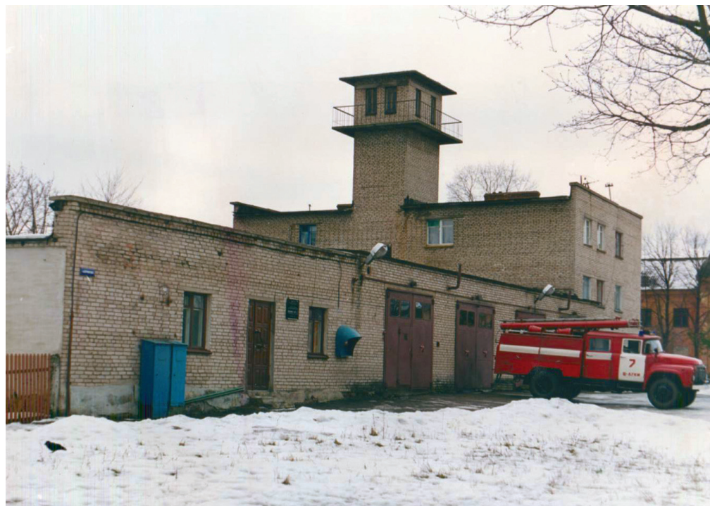
Здание пожарной части № 7 (ул. Корниенко, 3)
