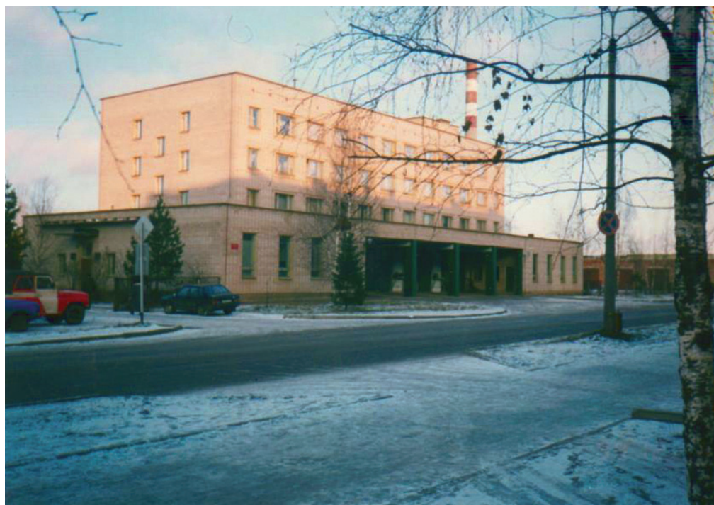
Здание пожарной части № 5 (ул. Дружбы, 6)
