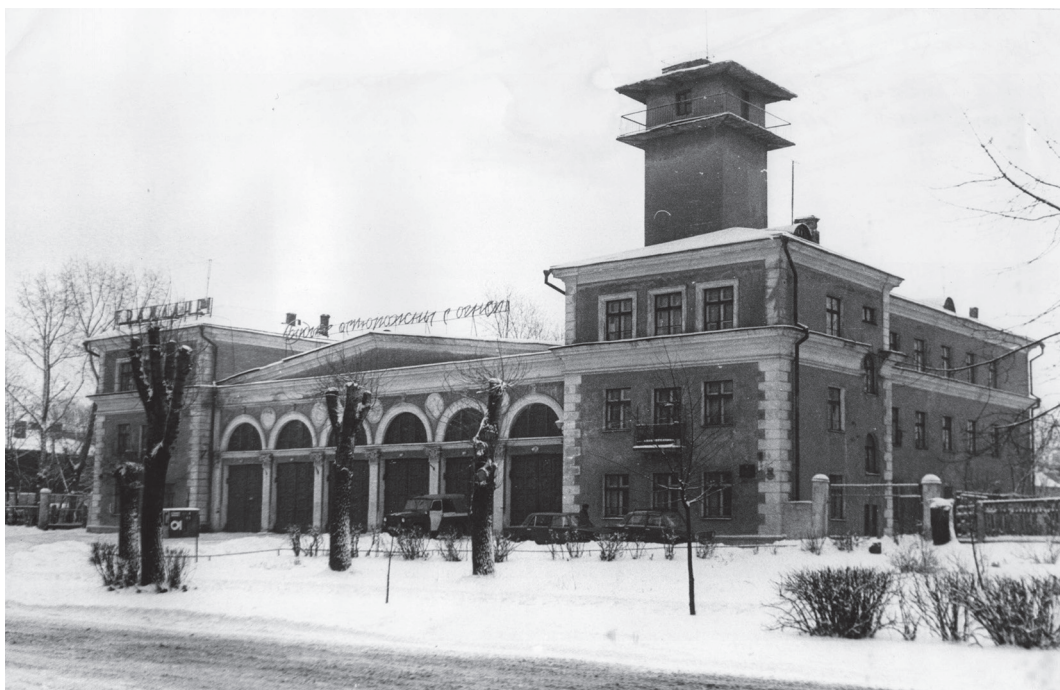
Здание пожарной части № 6 (Октябрьский пр., 45)
