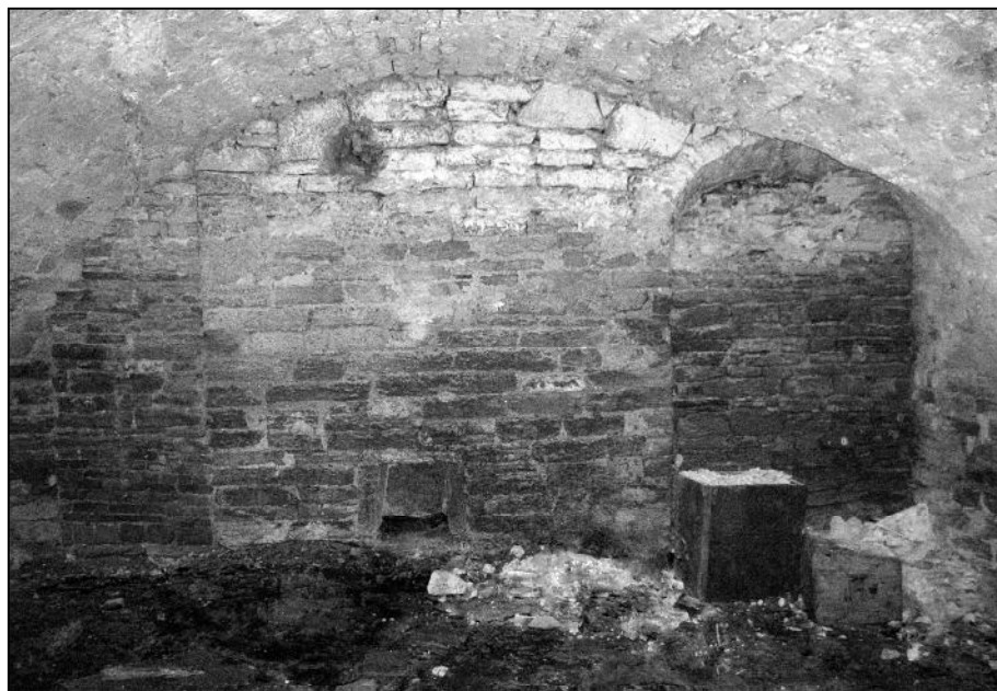
Рис. 17. Южная стена подсенья. Слева заложенный оконный проем, справа заложенный дверной проем.
