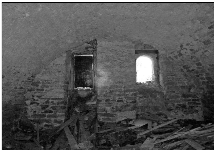
Рис. 22. Западная стена западного подклета. Оконные проемы.
