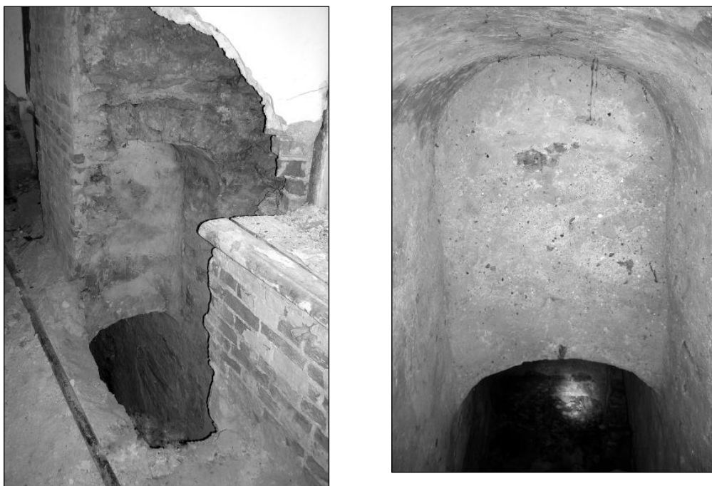
Рис. 20. Фрагменты внутрстенных лестниц.
